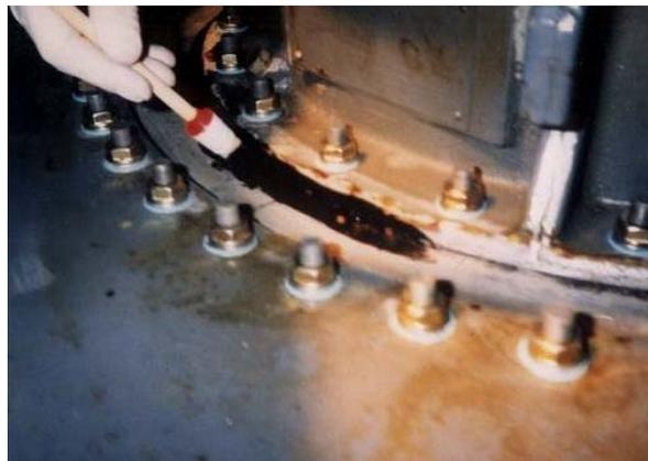
Variante 2: Die Undichtigkeit ist so beschaffen, dass nach dem Abwischen das Öl sofort bzw. innerhalb kurzer Zeit wieder sichtbar wird. Diese Variante ist vor allem dann zu wählen, wenn die Baugruppe (z.B. bei ölarmen Schalter mit Federspeicherantrieb) durch Schaltungsvorgänge oder Vibration belastet wird. Hier muss das Öl zunächst mit dem PolymerMetall MM-metall oL-StahlKeramik gebunden werden. Anschließend ist überdeckend auf das PolymerMetall das kalt aushärtende MM-Elastomer aufzutragen.
