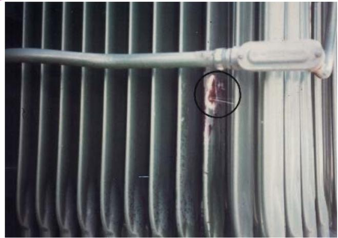
Variante 4: Leckagen an beschädigten Bauteilen, die nicht Vibrationen oder anderen Bewegungen ausgesetzt sind, können durch die alleinige Applikation des PolymerMetalls MM-metall oL-StahlKeramik abgedichtet werden.
