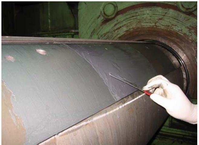
Durch Abrasion kam es an einer Wickelmaschine zum Verschleiß. Nachdem die zu behandelnde Oberfläche aufgeraut wurde, wurde sie mit dem PolymerMetall MM-metall SS-Stahl beschichtet und somit wieder instand gesetzt.
