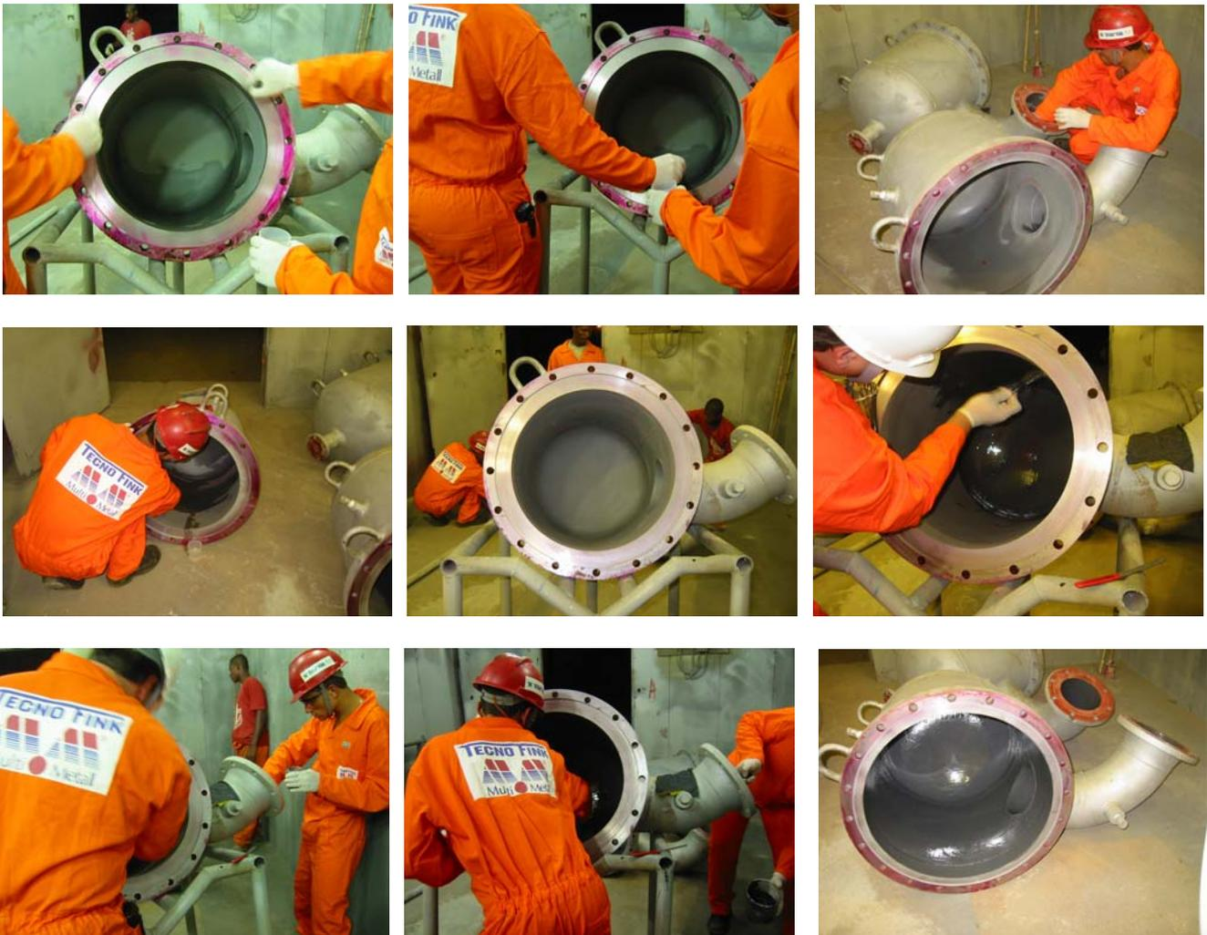
Mehrere schadhafte Abdeckungen eines Wärmetauschsystems wurden mit VP 10-017 repariert.
