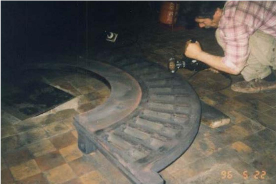
Wiederherstellung der Dichtfläche an der Abdeckung einer Turbine. Die Reparatur wurde mittels Ceramium, flüssig und Härter CE bei einer Stromerzeugungsstation vorgenommen.
