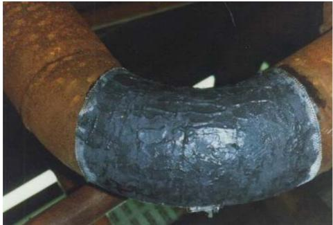
Abdichten einer Warmwasserleitung in einem Heizkraftwerk mit MM-metall UW und Härter UW9 zusammen mit MM-Gewebeband.
